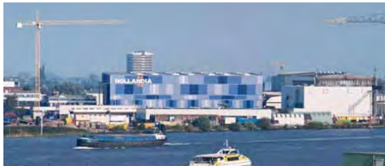
Hollandia Scheepswerf, Zwijndrecht (NL) Metropolis Architecten, 2005 Vloeroppervlak: 3.200m 2 (hoogte: 25m)
