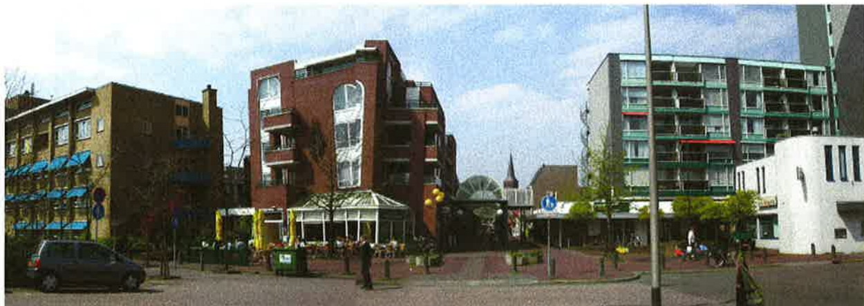
stedelijke entree_onduidelijk en rommelig
