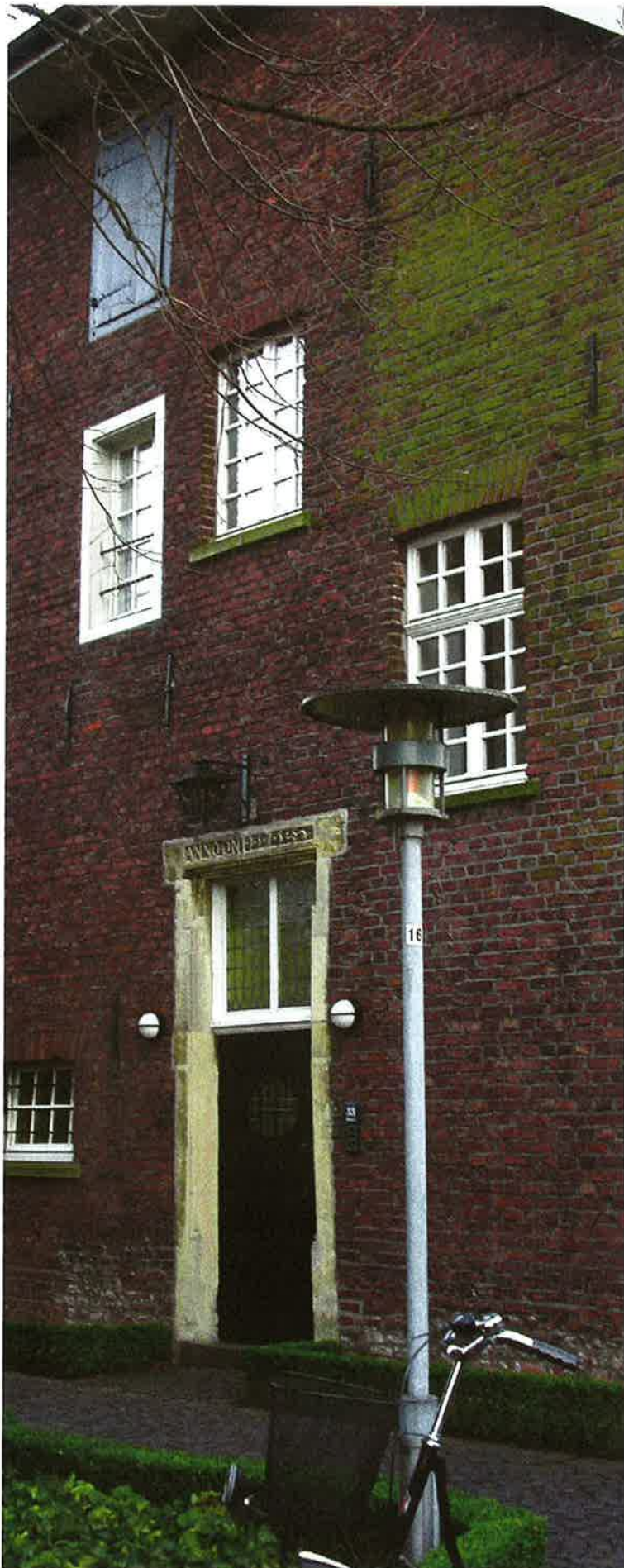
voorbeeld van een Nederrijnse woning uit Goch (D)
