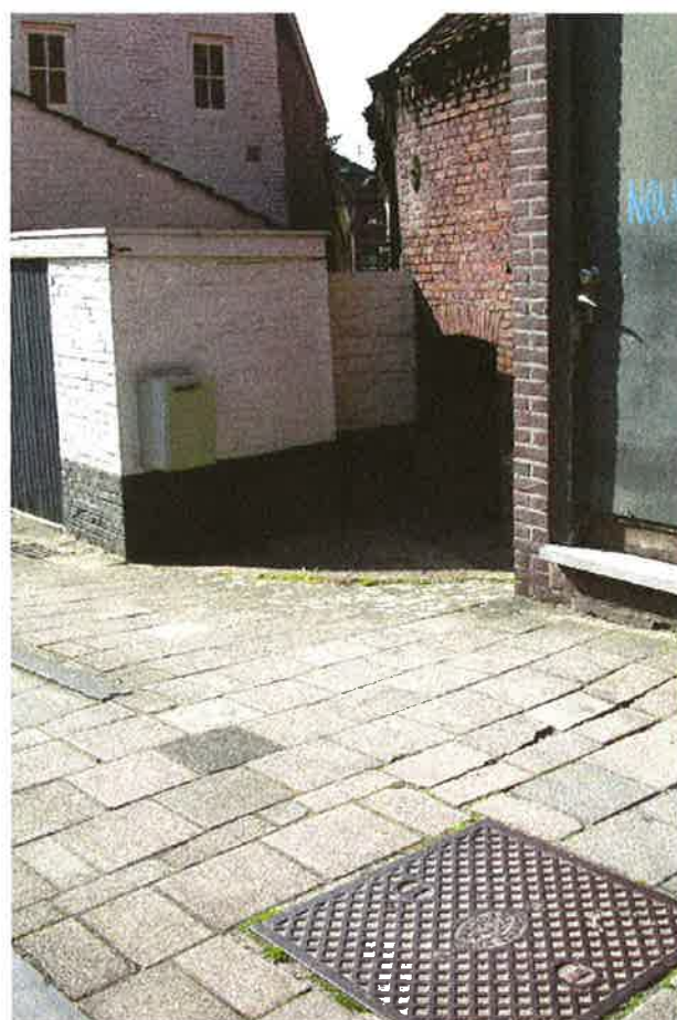
de Engerbeek, overgang van oorspronkelijke bedding en riool
