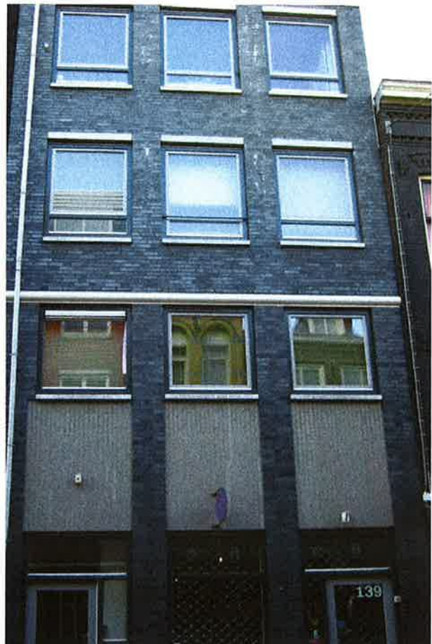
referentie pand in eigentijdse bouwstijl
