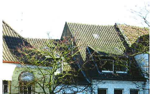
referentie gevelwand_elk pand een eigen dak
