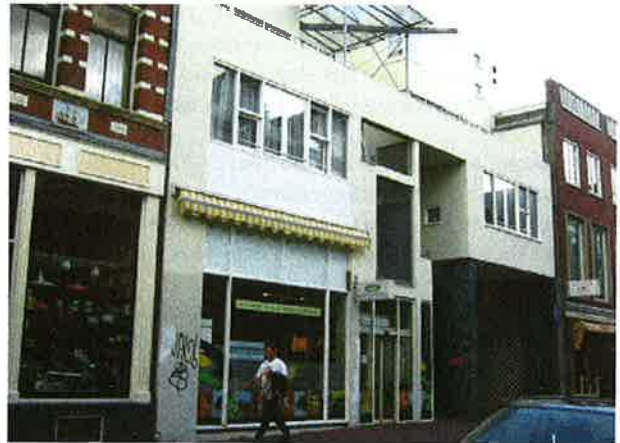
referentie pand in eigentijdse bouwstijl
