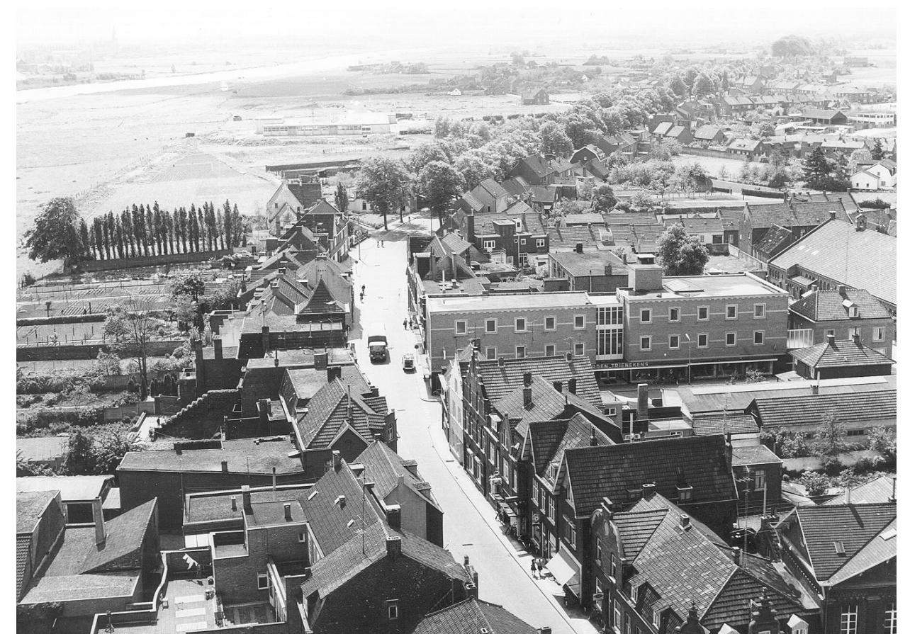
Afb. 12) Zicht vanaf de kerktoren op de Pontanusstraat, circa 1960. Op de hoek Pontanusstraat/Laurentiusstraat is na de Tweede Wereldoorlog nieuwbouw verrezen (Foto gemeente-archief Venlo).
