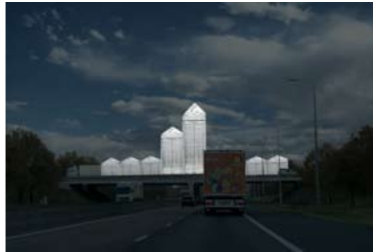
Viaduct A67, Weselsweg
