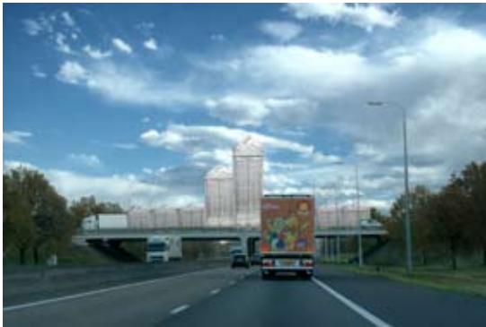
Viaduct A67, Weselsweg
